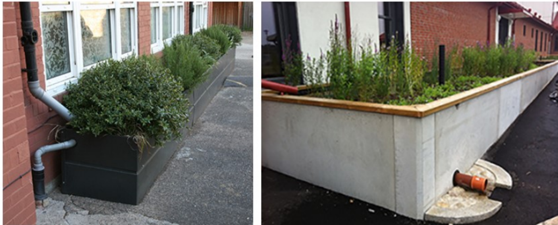
Figur 18 Biofilter i upphöjd planteringslåda. (Bildkälla: rent-dagvatten.se)
